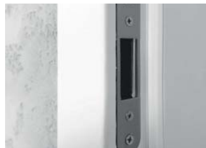
čelo magnetického zámku v dveřním rámu
